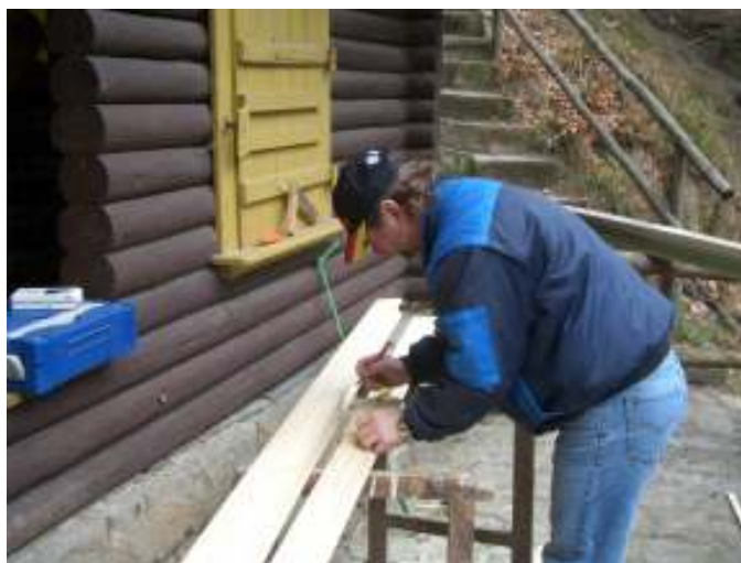
U. Prell bei Zuschnittarbeiten
