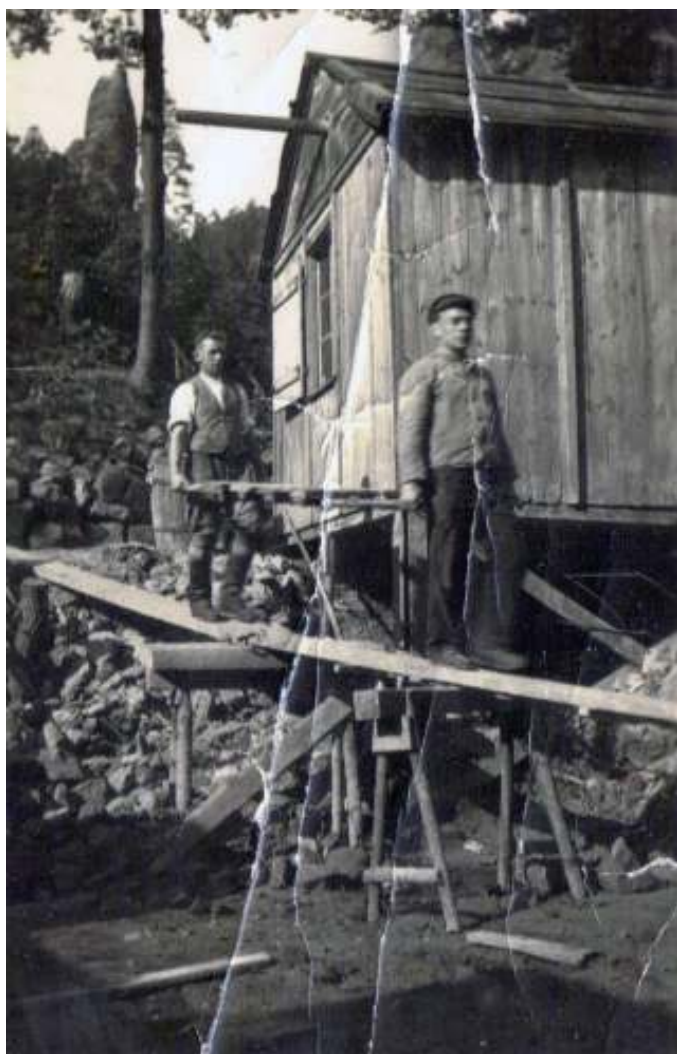
Bauarbeiter an der Staumauer Heller,Walter / Richter,Paul
