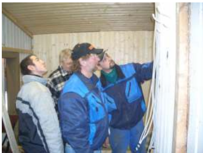
v.l.n.r. M. Dittrich, P. Langmann, U.Prell, und J. Muschialik bei Holzverschalungsarbeiten
